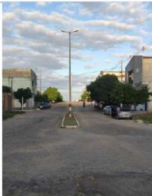
TRECHO FINAL DA RUA ANANIAS MONTEIRO
