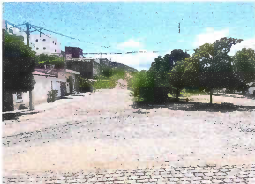
Início da pavimentação da rua Governador Dix-Sept Latitude '6° 39' 58,31" S - Longitude 37°24' 11,55" O
