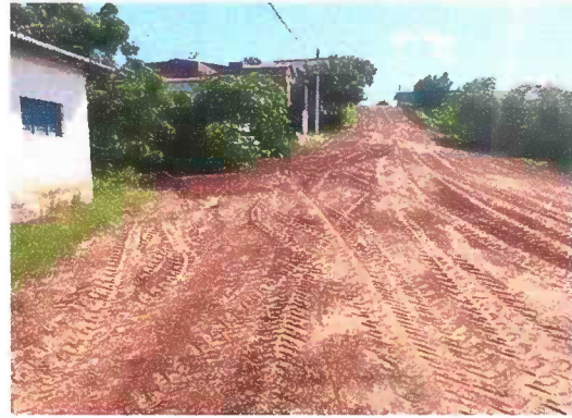
rua Epaminondas Belo - lado direito vista de trecho intermediário
