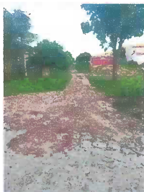
Início da pavimentação da rua Rubens Vanderlei Latitude '6° 39' 58,31" S - Longitude 37°24' 11,55" O
